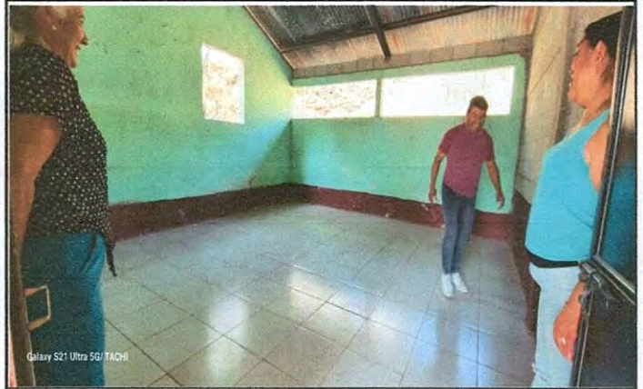
Foto 2: MEJORAMIENTO DE PISO DE AULAS
