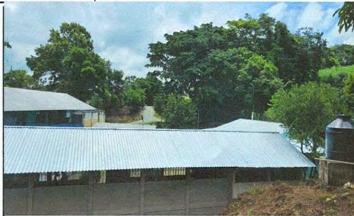
Foto 1: MEJORAMIENTO DE TECHO DE AULAS
