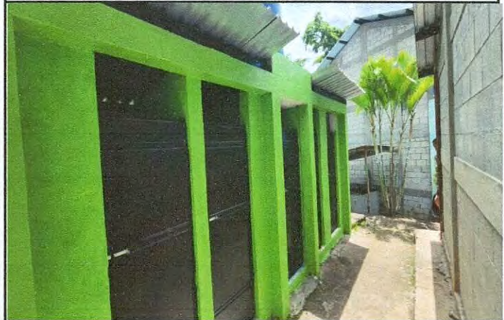
Foto 4: MEJORAMIENTO MODULO DE BAÑOS
