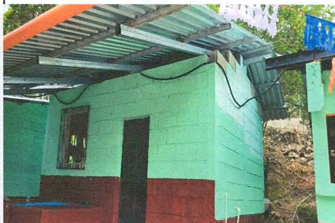
Foto 4: MEJORAMIENTO DE TECHO Y VENTANAL COCINA
