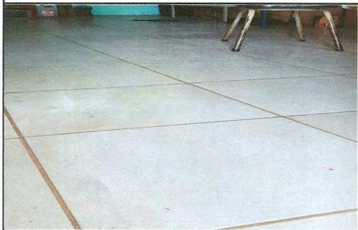
Foto 3: MEJORAMIENTO DE AULA, PISO
