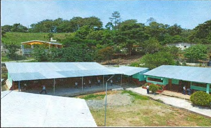
Foto 1: MEJORAMIENTO DE TECHO DE AULAS Y COCINA
