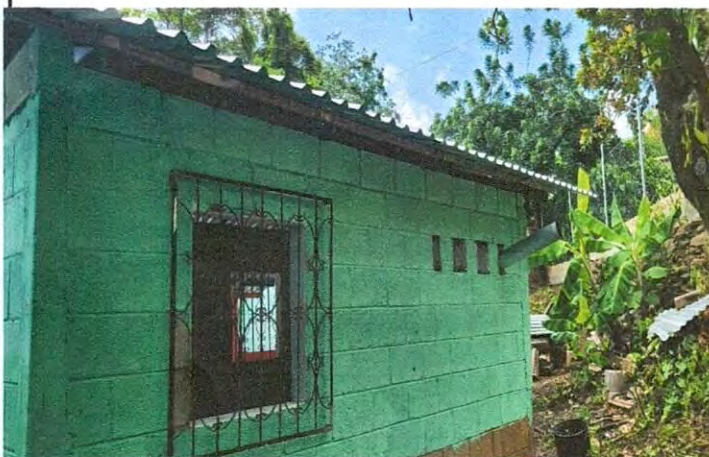
Foto 3: MEJORAMIENTO DE TECHO Y VENTANAL COCINA
