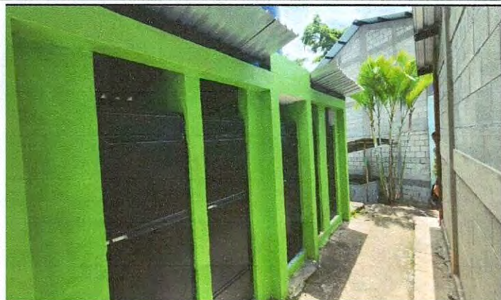
Foto 1: MEJORAMIENTO DEMODULO DE BAÑOS
