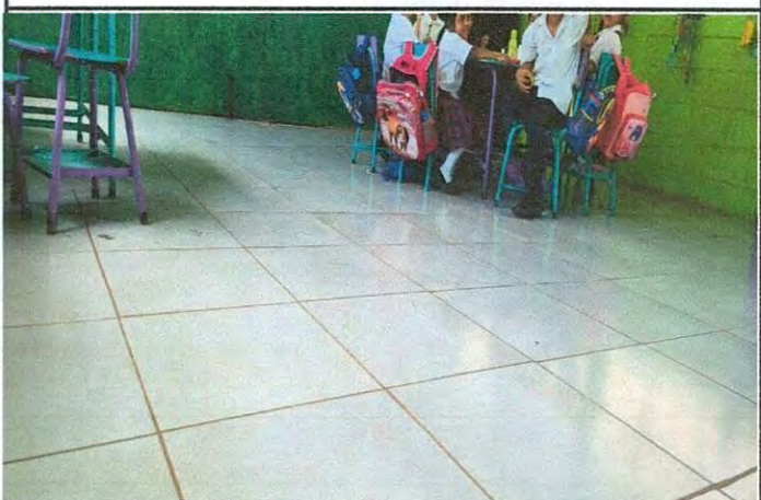
Foto 4: MEJORAMIENTO DE AULA, PISO
